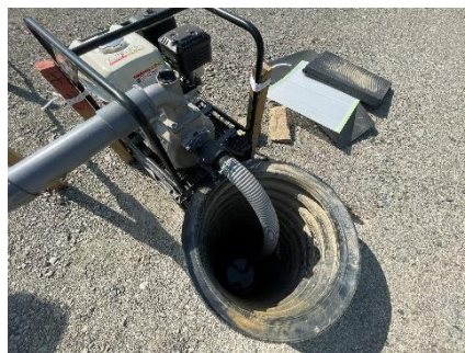
水源確保のためのエンジンポンプ
